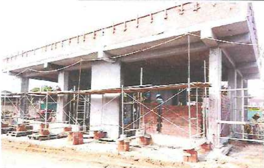
Tarrajeo de superficies de columnas, vigas, placas, derrames y cisoraso en el Módulo A-2.
