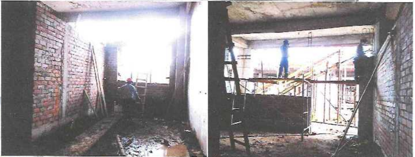
Trabajos de habilitado de acero y encofrado de vigas de confinamiento en Módulo D.
