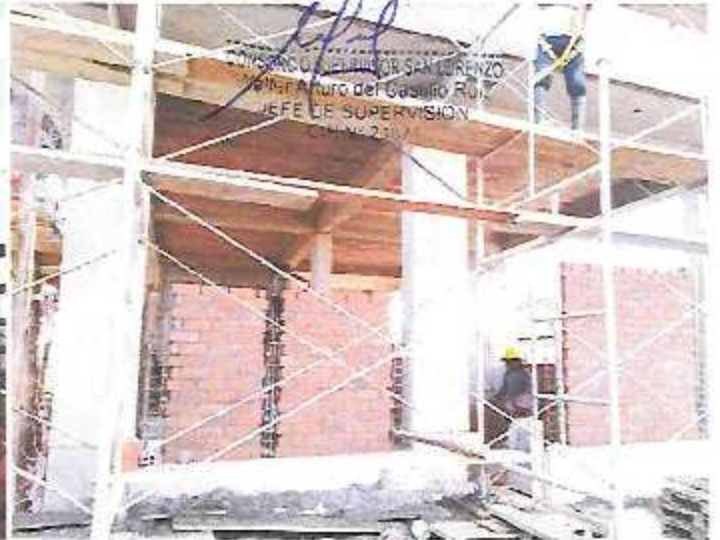
Trabajos de tarrajeo en columnas, parapetos, vigas y derrames en el Módulo A-2.
