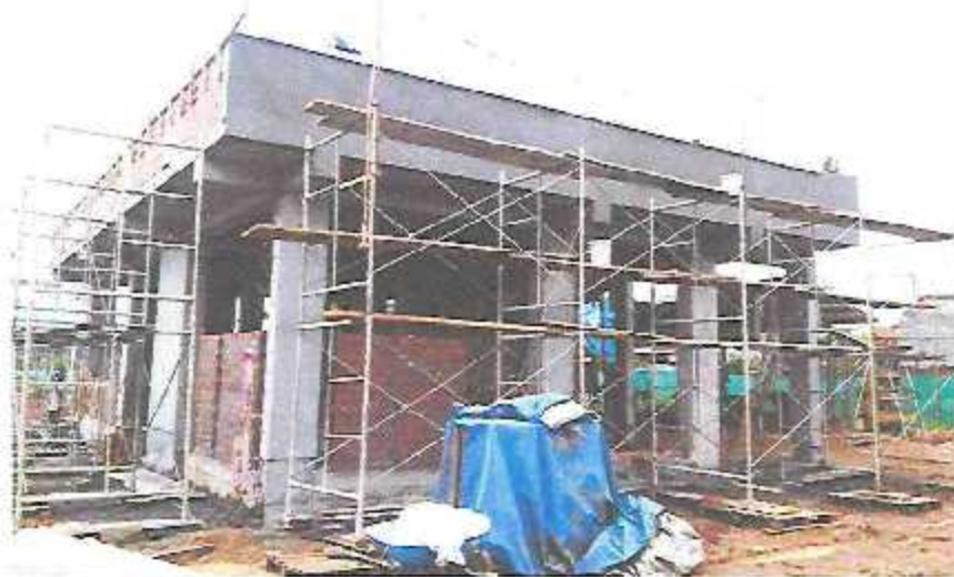
Trabajos de tarrajeo en columnas, parapetos, vigas y derrames en el Módulo C-3.
