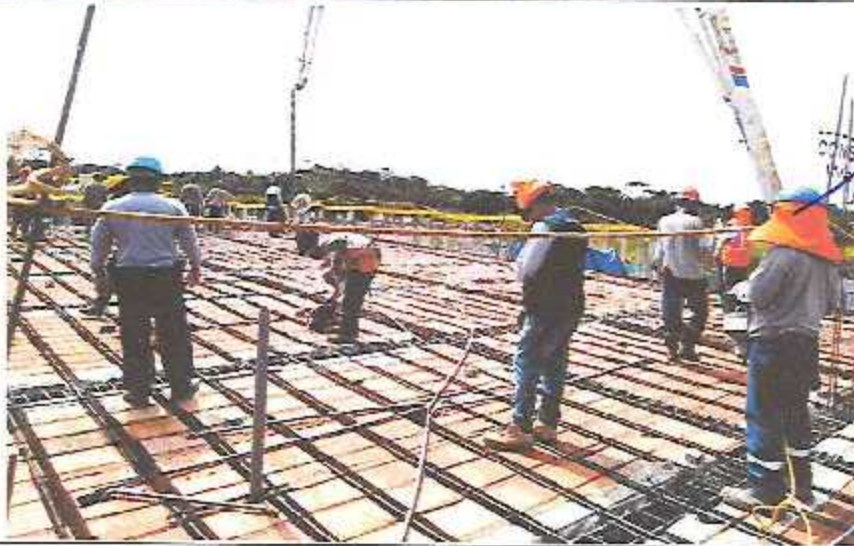
Trabajos de vaciado de concreto f_c = 210 \text{ Kg/cm}^2 en losa aligerada en el Módulo C-3
