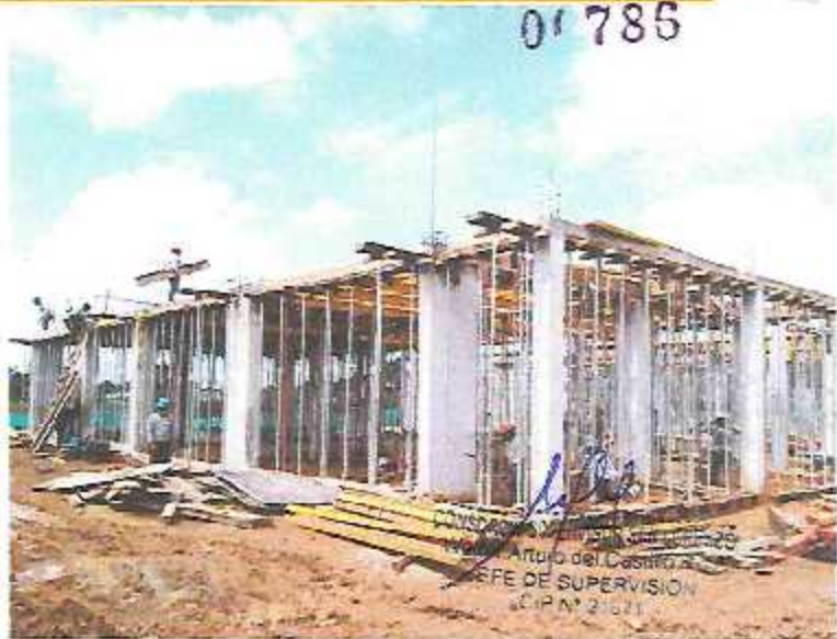
Trabajos de encofrado de fondos de vigas principales y viguetas de losa aligerada en Módulos E-2.
