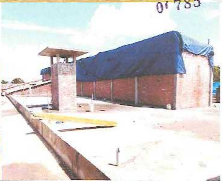
Limpieza general en zona de parapetos, timpanos, sardinel pluvial sobre losa aligerada en Módulo A-1.
