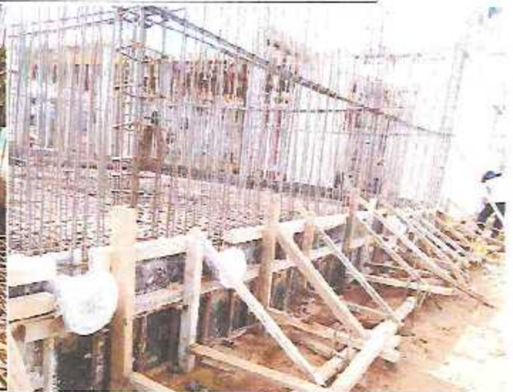
Trabajos de habilitado de acero y colocación de 03 bridas de acero en cisterna, en el Módulo E-3.
