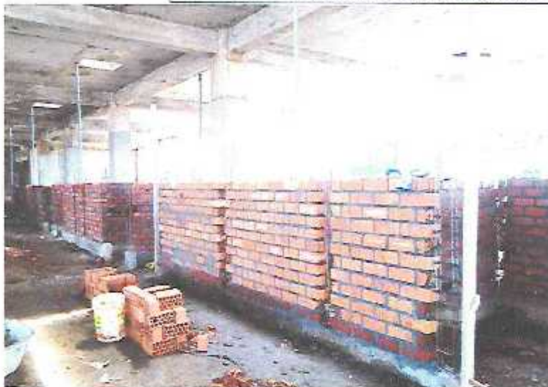
Asentado de ladrillos en aparejo de soga y encofrado de columnetas y vigas de confinamiento en Módulo D.
