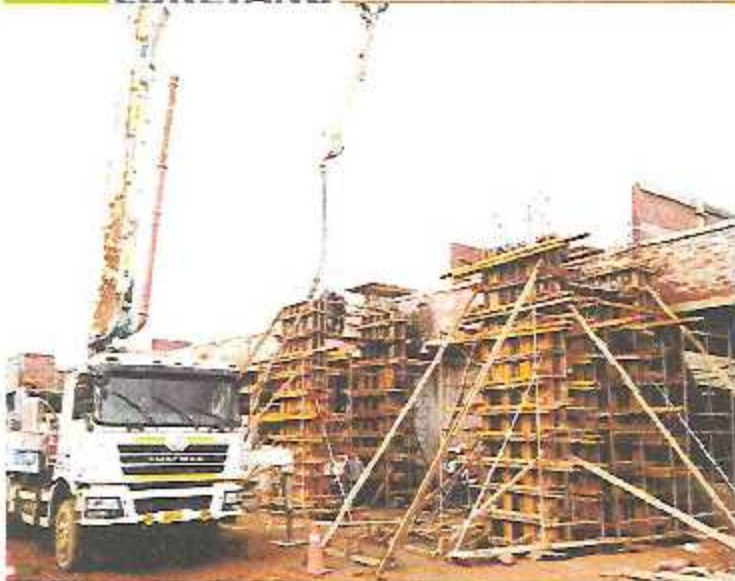
✓ Vertido de concreto f_c = 210 \text{ Kg/cm}^2 en placas del Ingreso Principal Cobertura 02 - frente a Módulo A-1 / Sector 3 e Ingreso N° 04 - frente a Módulo A-2.
