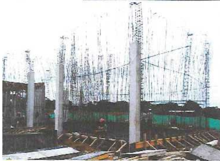
Trabajos de habilitado de acero y encofrado de la platea de cimentación de la cisterna en el Módulo E-3.
