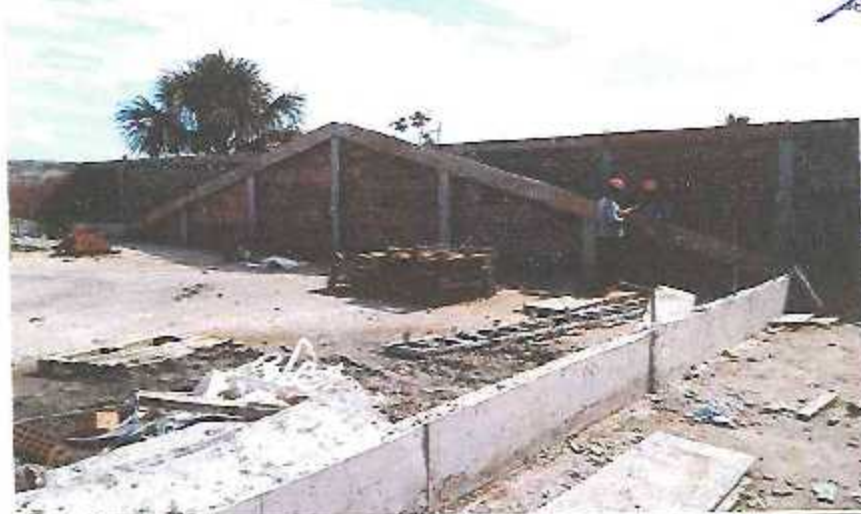
Encofrado de vigas en timpano en el módulo A - Sector 6.
