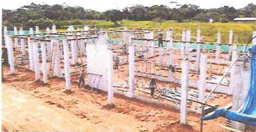
Trabajos de encofrado fondos de vigas en losa aligerada en Módulos E-2 y E-3.
