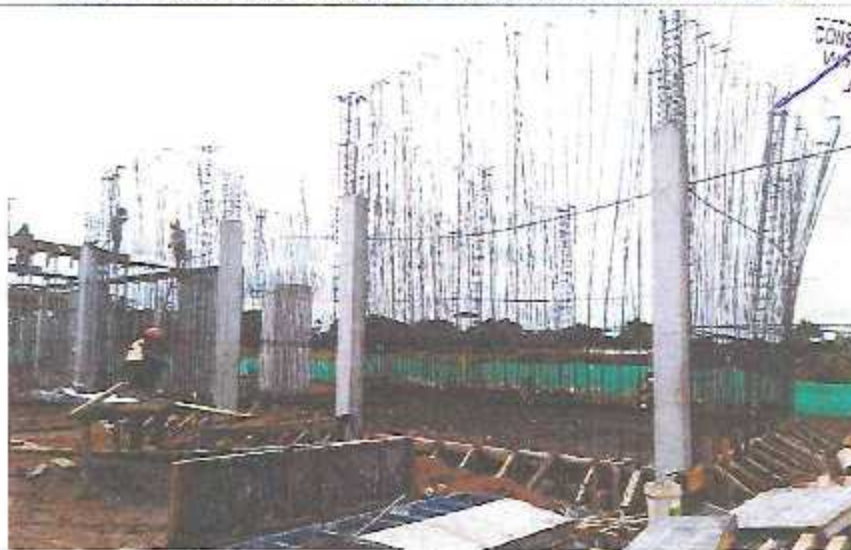
Trabajos de encofrado de la platea de cimentación de la cisterna en el Módulo E-3.
