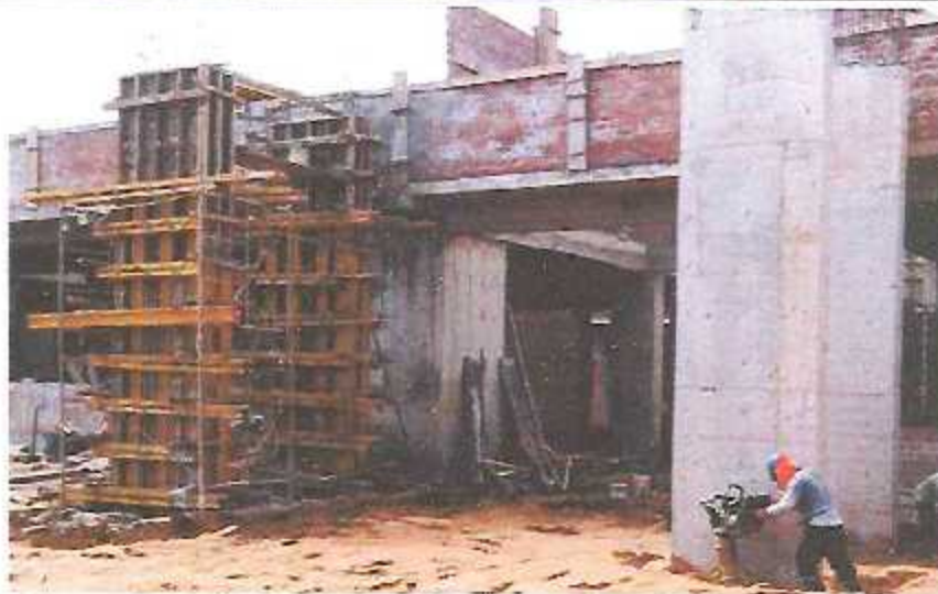
Acabado de placas, relleno zona de zapatas con material propio y compactación con canguro - Ingreso Principal Cobertura 02 - frente a Módulo A/ Sector 3.
