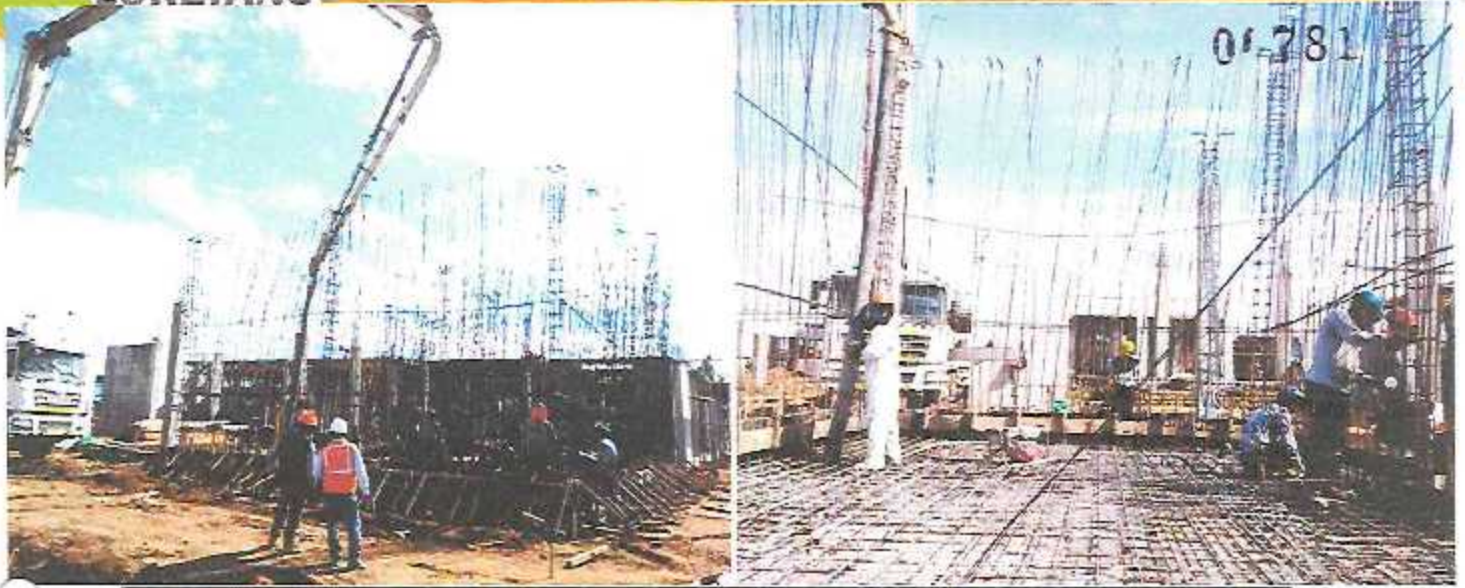
Trabajos de vaciado de concreto f_c = 280 \text{ Kg/cm}^2 en platea de la cisterna, con apoyo de mixer y bomba telescópica.
