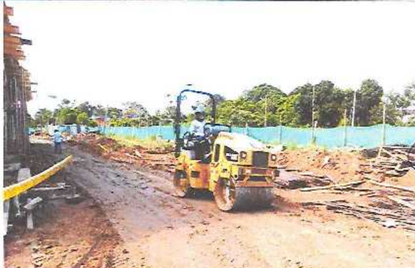
Trabajos de mantenimiento de vías de acceso con rodillo, en obra de Hospital San Lorenzo.
