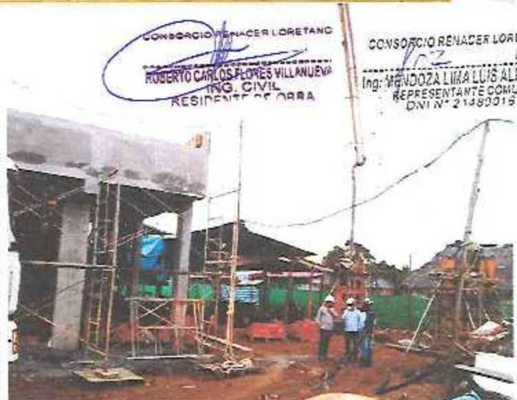
✓ Vertido de concreto f_c = 210 \text{ Kg/cm}^2 en placas del Ingreso Principal Cobertura 02 - frente a Módulo A-1 / Sector 3 e Ingreso N° 04 - frente a Módulo A-2.
