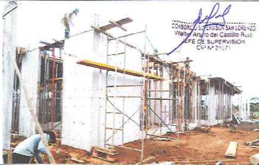
Trabajos de encofrado de fondos de vigas principales y viguetas de losa aligerada en Módulos E-2 y E-3.
