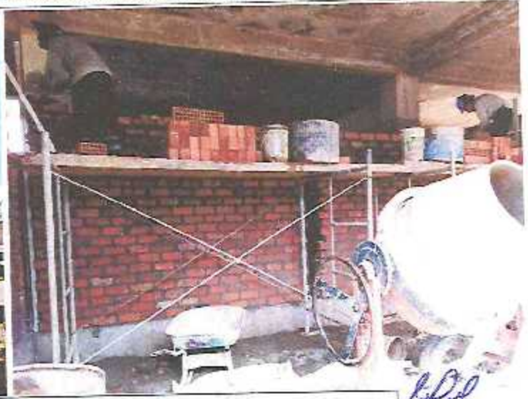
Asentado de ladrillos en aparejo de soga y encofrado de columnetas y vigas de confinamiento en Módulo B-1.
