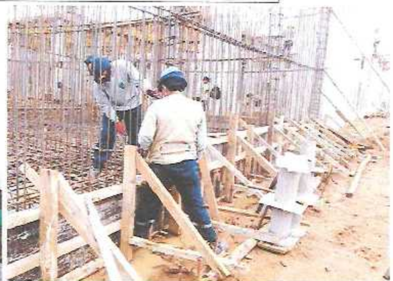
Trabajos de habilitado de acero y encofrado de la platea de cimentación de la cisterna en el Módulo E-3.
