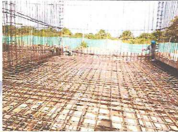
Trabajos de habilitado de acero y colocación de 03 bridas de acero en cisterna, en el Módulo E-3.
