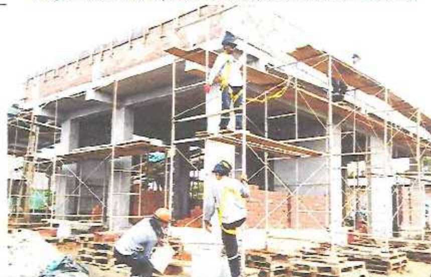
Trabajos de tarrajeo en columnas, parapetos, vigas y derrames en el Módulo A-2.
