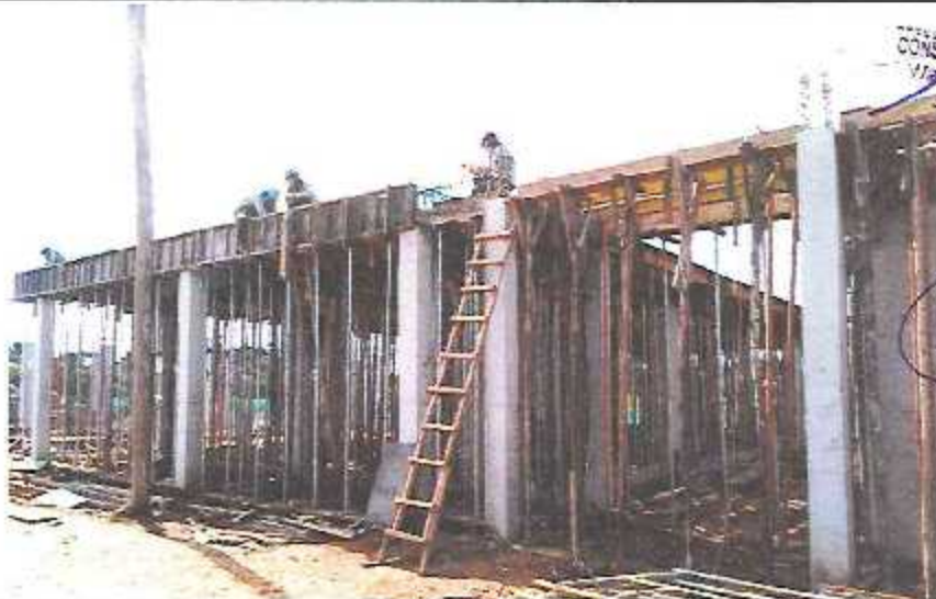
Trabajos de encofrado de vigas principales y viguetas de losa aligerada en Módulos E-2.
