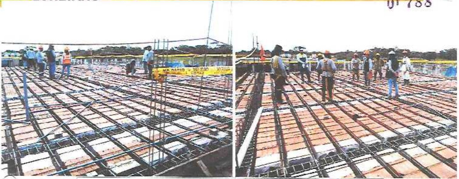
Charlas de inducción a personal de obra para el vaciado de concreto en losa aligerada en Módulo C-3.
