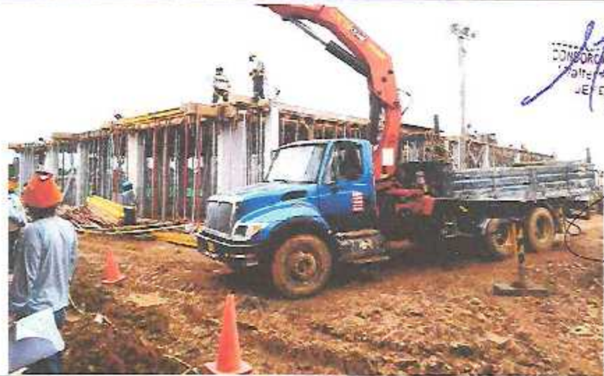
Trabajos de encofrado de fondos de vigas principales y viguetas de losa aligerada en Módulos E-2.
