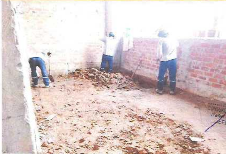
Trabajos de corte de terreno a nivel de subrasante en ambientes del Módulo D.
