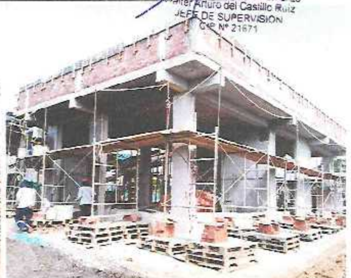
Tarrajeo de superficies de columnas, vigas, placas, derrames y cisoraso en el Módulo A-2.
