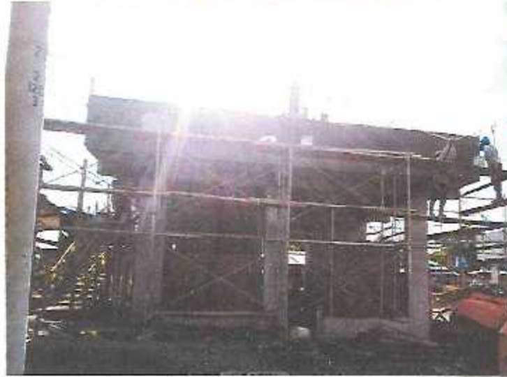
Trabajos de tarrajeo en columnas, parapetos, vigas y derrames en el Módulo A-2.
