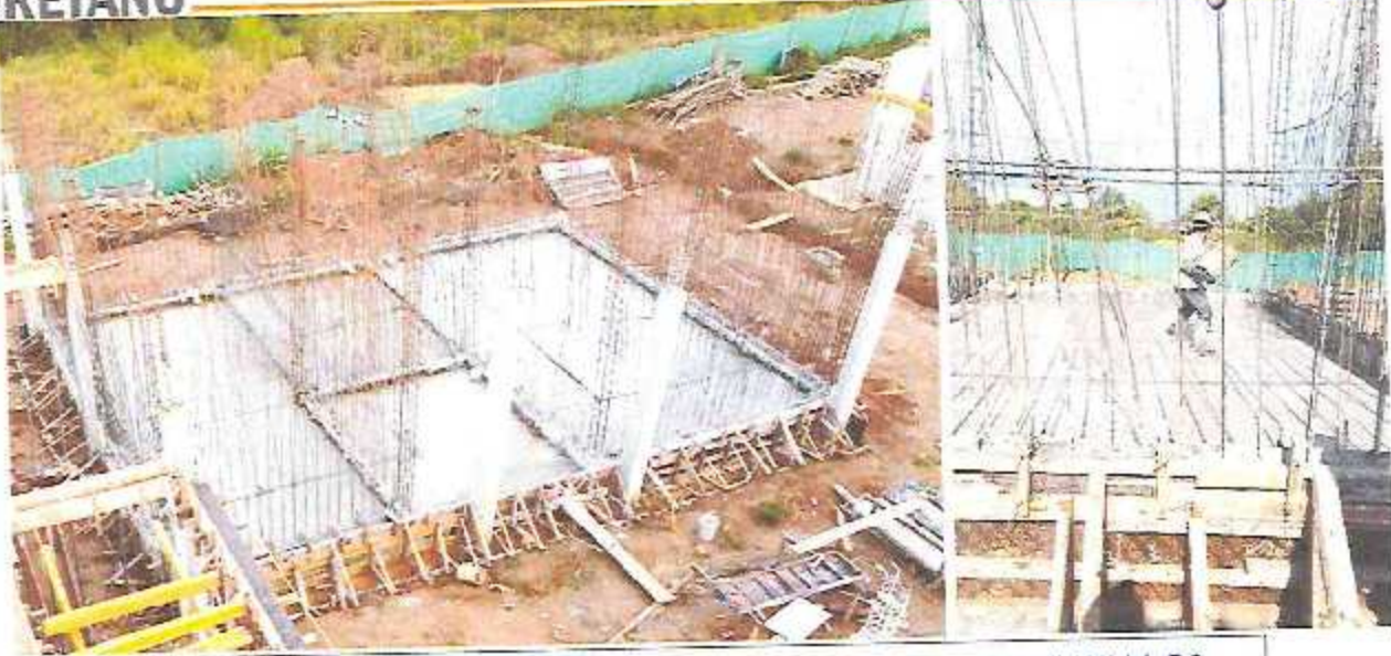
Vista del vaciado de concreto de la platea de cimentación y curado de la cisterna del Módulo E-3.
