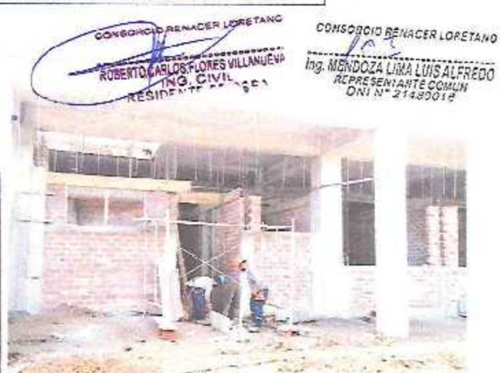
Asentado de ladrillos en aparejo de soga y encofrado de columnetas y vigas de confinamiento en Módulo D.
