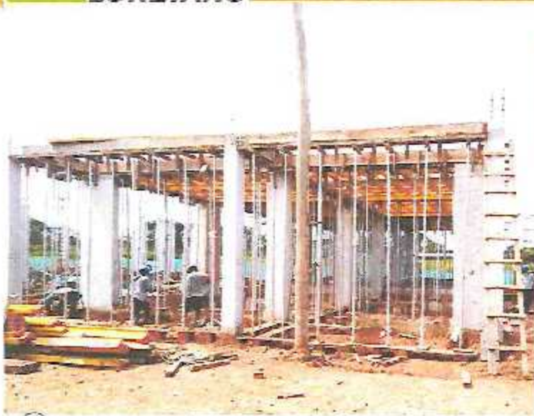
Trabajos de encofrado de fondos de vigas principales y viguetas de losa aligerada en Módulos E-2.
