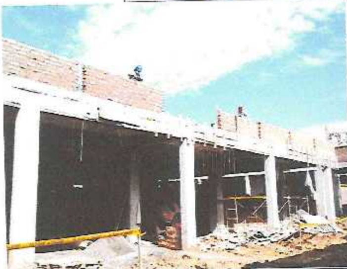
Asentado de ladrillos en aparejo de soga y encofrado de columnetas y vigas de confinamiento en Módulo B-1.
