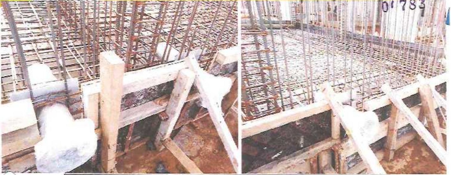
Trabajos de colocación de 03 bridas de acero (agua dura, agua blanda y agua) en cisterna, en el Módulo E-3.
