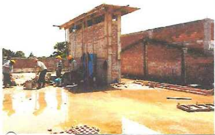
Limpieza general en zona de parapetos, timpanos, sardinel pluvial sobre losa aligerada en Módulo A-1.
